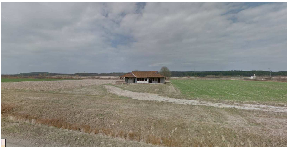
0148/2 hrsz ingatlan romos épülete
